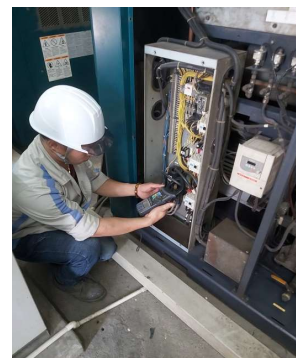
Bước 9: Kiểm tra dòng điện của máy và động cơ chính
