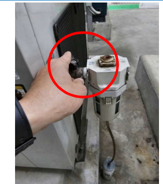
Bước 5: Mở van xả tự động FD6 của máy sấy khí
