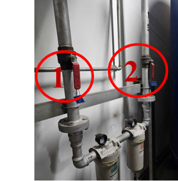
Bước 8: Chờ máy chạy ổn định sau đó mở lần lượt van số 1 và van số 2 đầu ra của máy sấy khí
