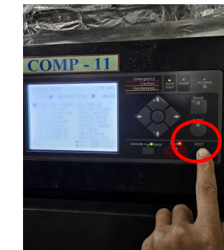
Bước 7: Nhấn nút: (START) để khởi động máy nén khí
