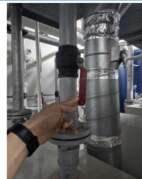
Bước 4: Kiểm tra và mở van đầu ra của máy nén khí
